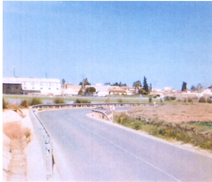
Curva con falta de alumbrado público
