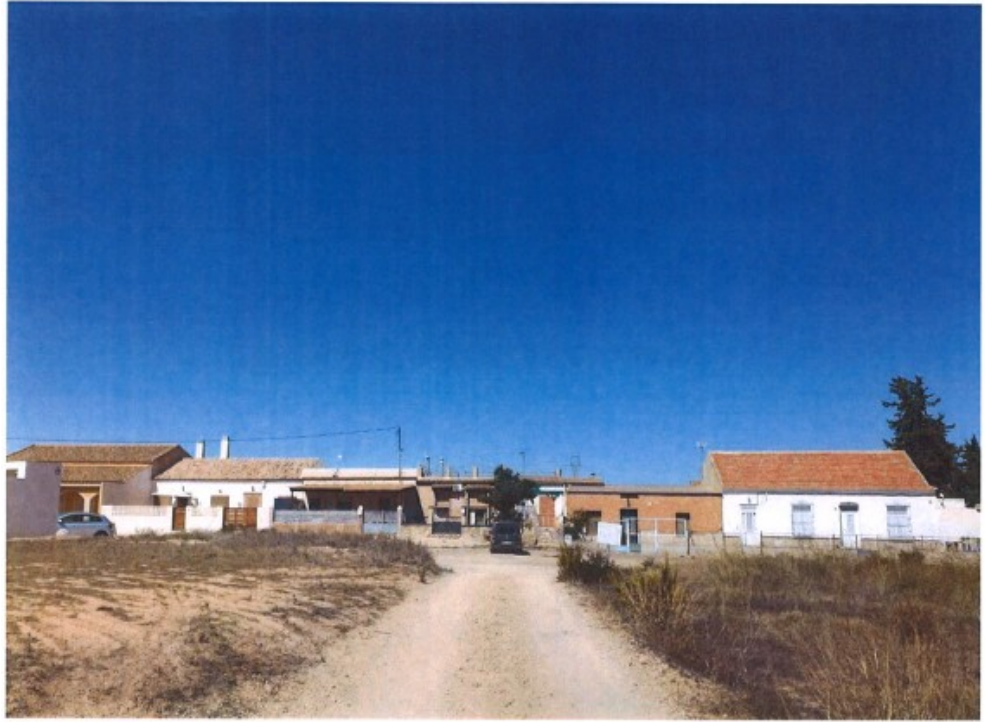
Vista de Los Piñuelas
