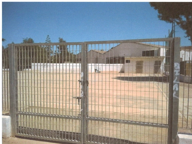
Pista deportiva en desuso
