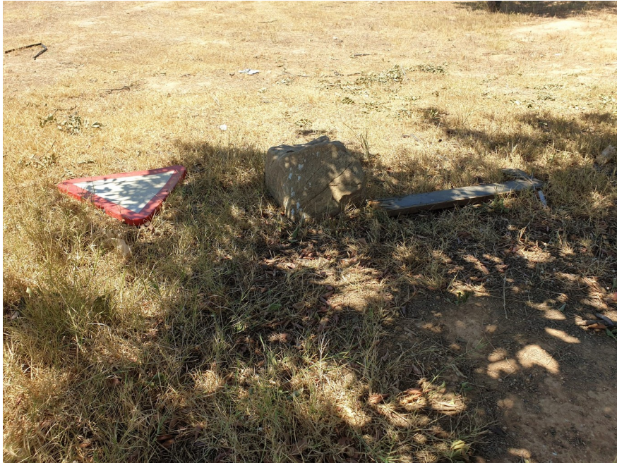
Derribo de señalización
